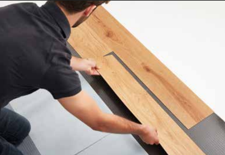
Spessore totale / Grosor total : 1,8 mm
